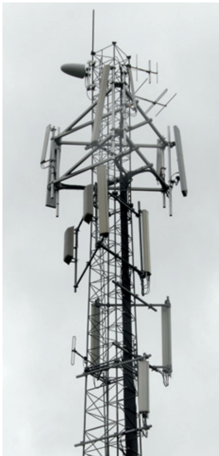
Basestasjoner for mobiltelefoni sender ut mikrobølger, men med svært mye lavere intensitet enn det vi finner inne i en mikrobølgeovn. Er denne formen for «stråling» farlig? WHO og andre har hittil ikke klart å konkludere. Foto Arnt Inge Vistnes
