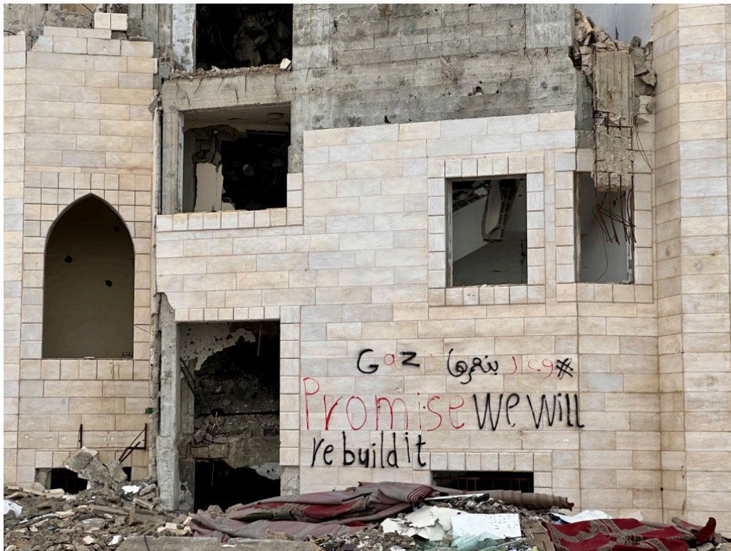
FRAMTIDSHÅP: Tagging på en bombeødelagt moské i Gaza by. Teksten lyder: «Gaza, vi lover at vi skal bygge opp igjen». Foto: Geir Stray Andreassen
