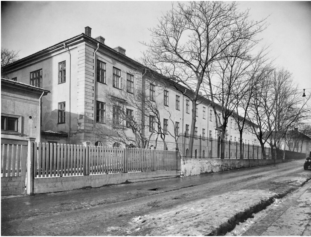
Figur 2 Murbygningen i rikshospitalanlegget. Fasade mot Grubbegata, ca. 1910–20. Foto: Olaf Martin Peder Væring/Oslo Museum/ Byhistorisk samling (CC BY-SA 4.0)
