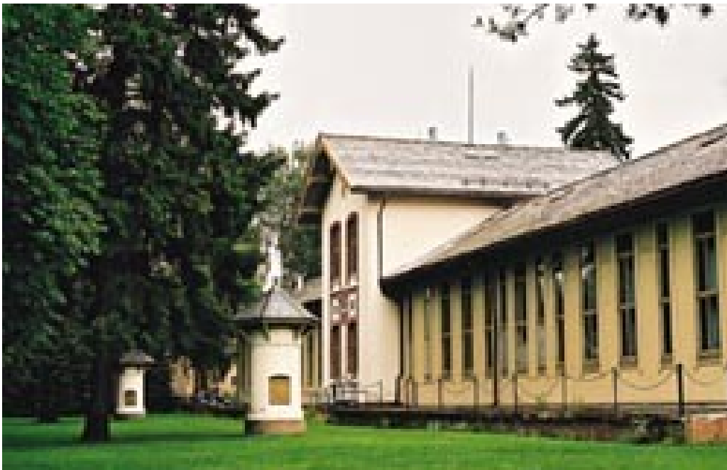
Figur 8 Epidemipaviljong med ventilasjonstårn, Ullevål sykehus, Oslo. Fra friskluftinntak i tårnene gikk kanaler inn til sykesalene med utlufting over tak. Foto Ø. Larsen 2000
